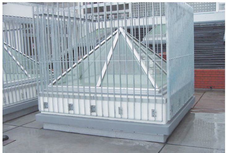
防護柵 (別途) を設置した例
