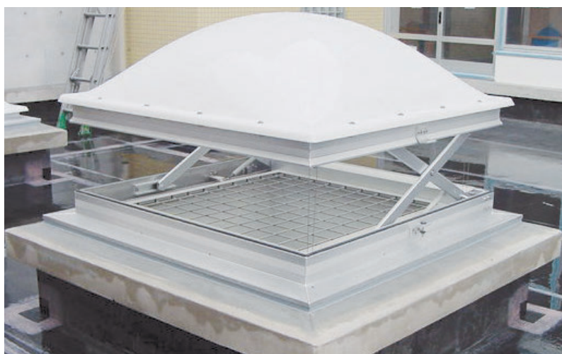
開閉式トップライトに落下防止ネットを設置した例
