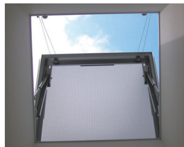
片側開閉 見上げ (開閉途中)
