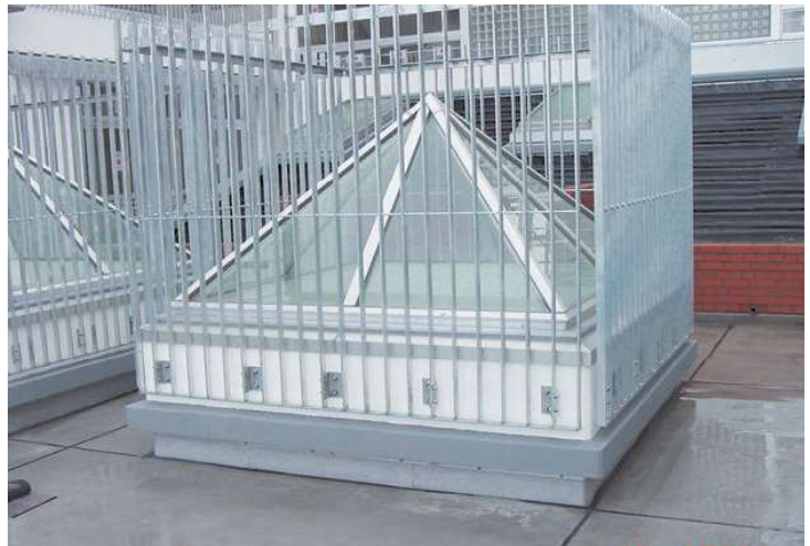
防護柵（別途）を設置した例
