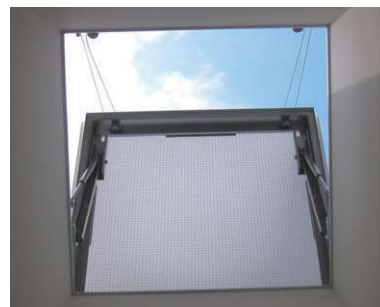
片側開閉 見上げ（開閉途中）
