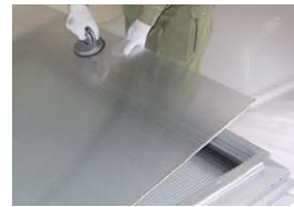
ガラスの上に中空シートを設置
