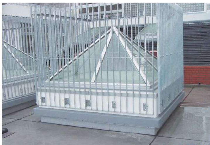
防護柵 (別途) を設置した例
