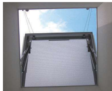
片側開閉 見上げ (開閉途中)
