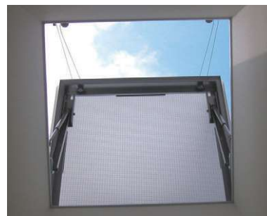
片側開閉 見上げ (開閉途中)
