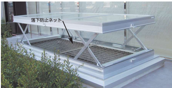
▲開閉タイプ例（開口部に落下防止ネットを設置）
