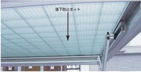
▲開閉タイプ例（ドーム下に落下防止ネットを設置）
