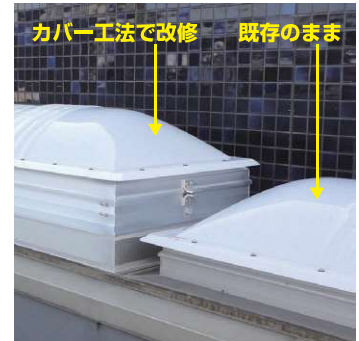
既存開閉トップライトの上に、新規開閉トップライトを設置した例
