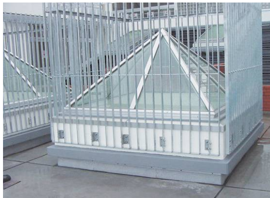
防護柵(別途)を設置した例
