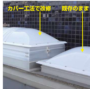
既存開閉トップライトの上に、新規開閉トップライトを設置した例
