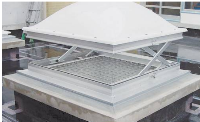
開閉式トップライトに落下防止ネットを設置した例
